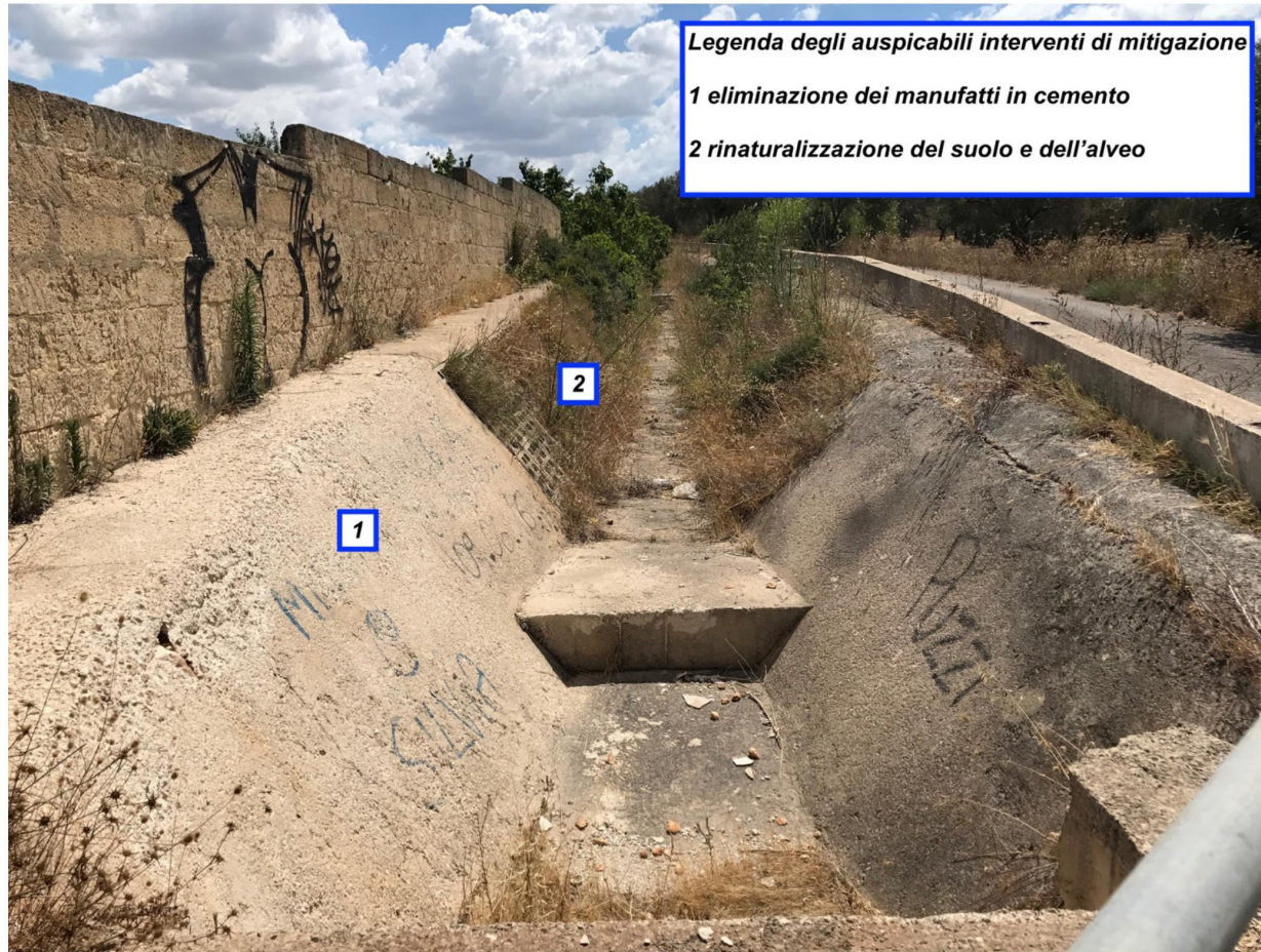
Foto 3 –situazione attuale località Varano, canale di bonifica cementificato-
