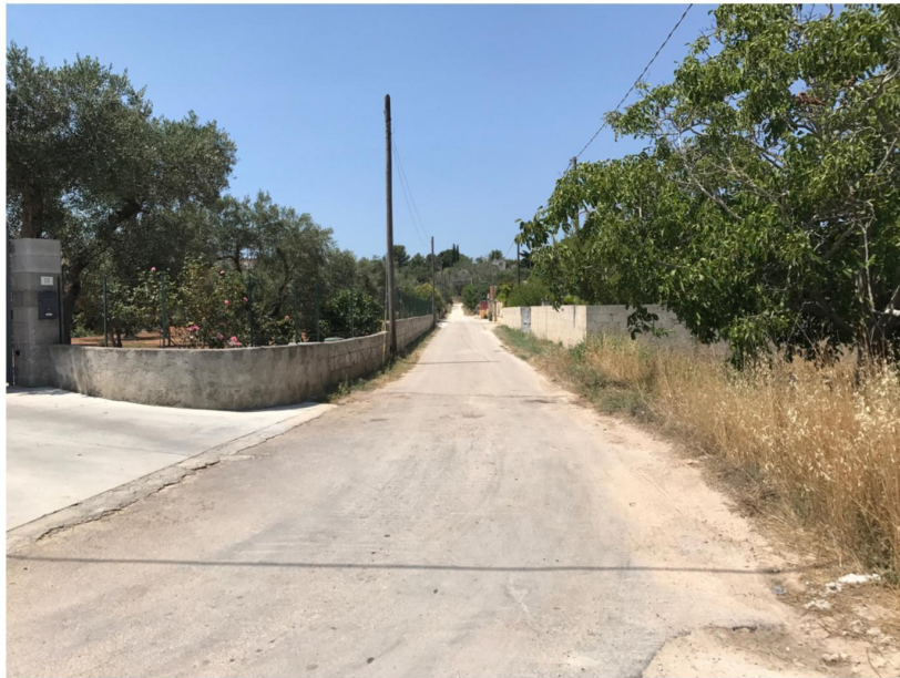
foto reale 2: viabilità rurale esistente
