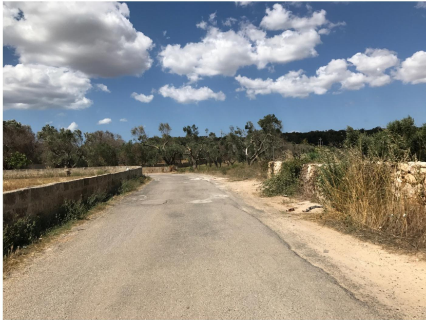
foto reale 7: viabilità rurale esistente
